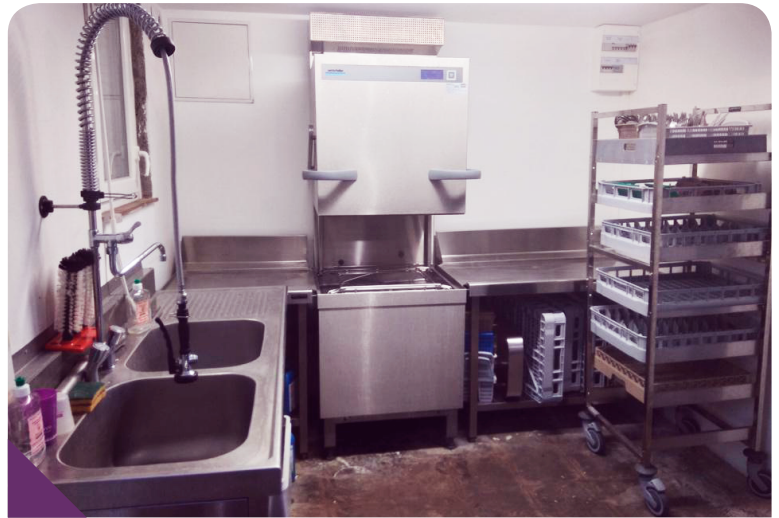
Espace de lavage d'Elémén'terre
